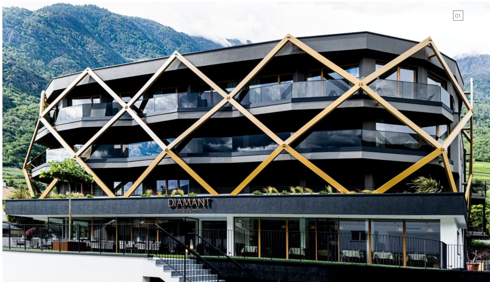
01 Aluminium Fassade in Form eines Diamanten 01 Facciata in alluminio a forma di diamante
